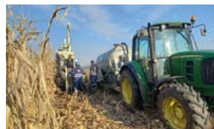
Aplikace organického substrátu EVO metodou direct push
