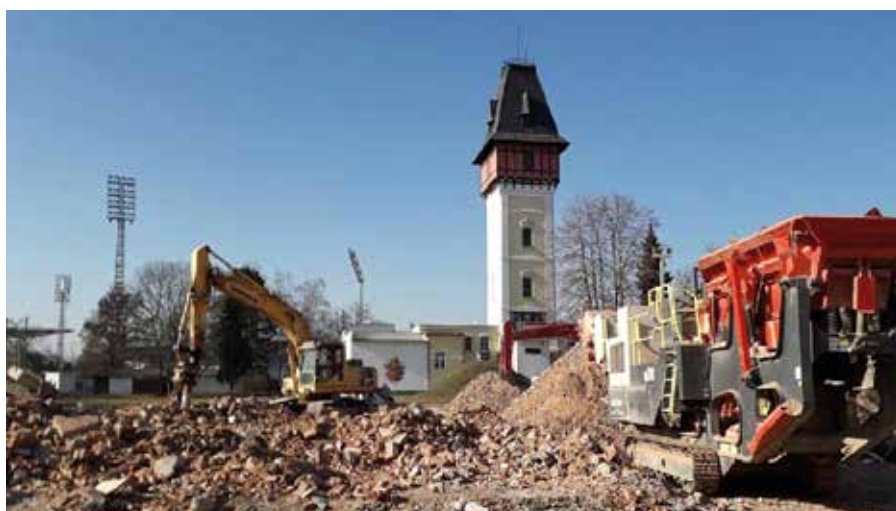
Recyklace v místě demolice stavby, České Budějovice, leden 2025. Smysluplné a udržitelné řešení
